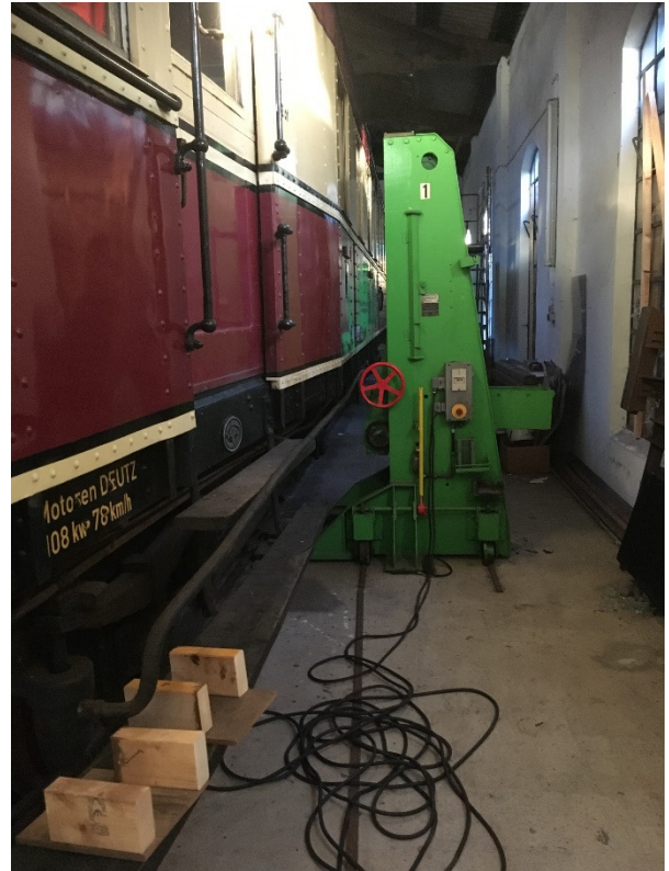
Vorbereitungen zum Anheben (Foto: J. Dammann)
