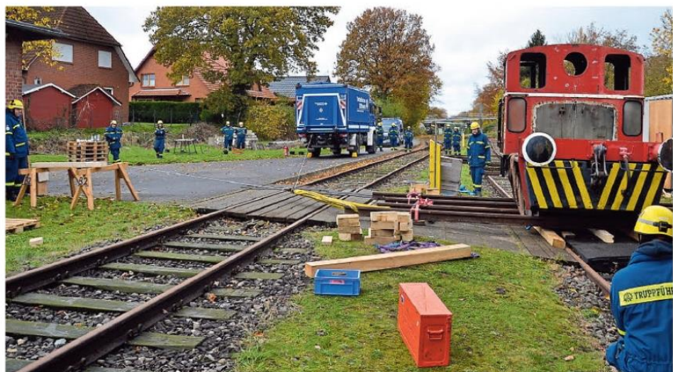
Vorbereitungen für einen schwierigen Teil: Damit die Lok zum Eingang der Fahrzeughalle kommt, muss sie um eine kleine Kurve gezogen werden Fotos: sc
